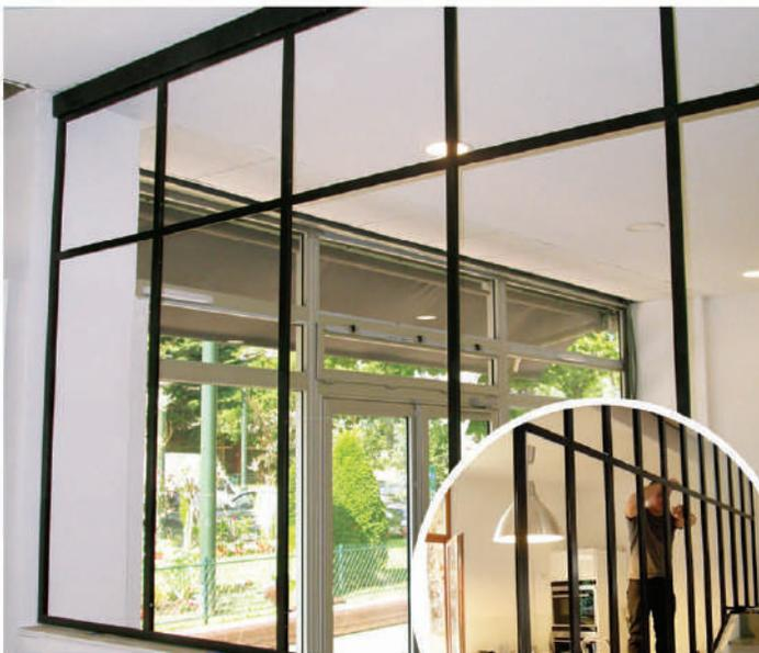
elle est idéale pour amener un éclairage naturel. Les verrières sont fabriquées en fer T de 35 mm et sont composées de vitrage feuilleté 33° maintenu par un film transparent et évitant tous risques de blessure en cas de casse. En kit prêt à poser ou en sur mesure, BaieEco propose trois gammes de verrières d'intérieur : la basic, la classique avec une imposte en partie haute et la traditionnelle avec une imposte et soubassement tôle.
